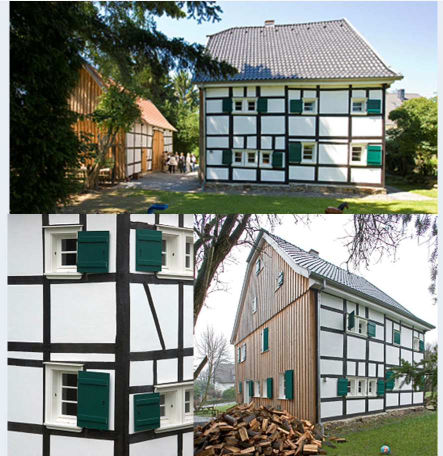
NRW, Leichlingen, Hülstrunk 49/51, Energieeffizienz im Denkmal, Wettbewerbssieger 2013, @DSD
